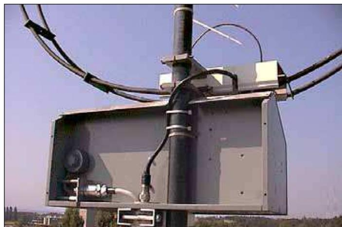
À l'arrière arrivée du coax et du câble de commande
